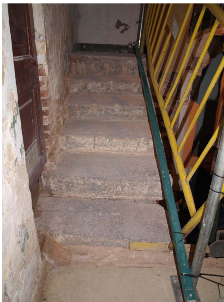
FOTO 2: Vista general de l'escala un cop va ser retallada.
