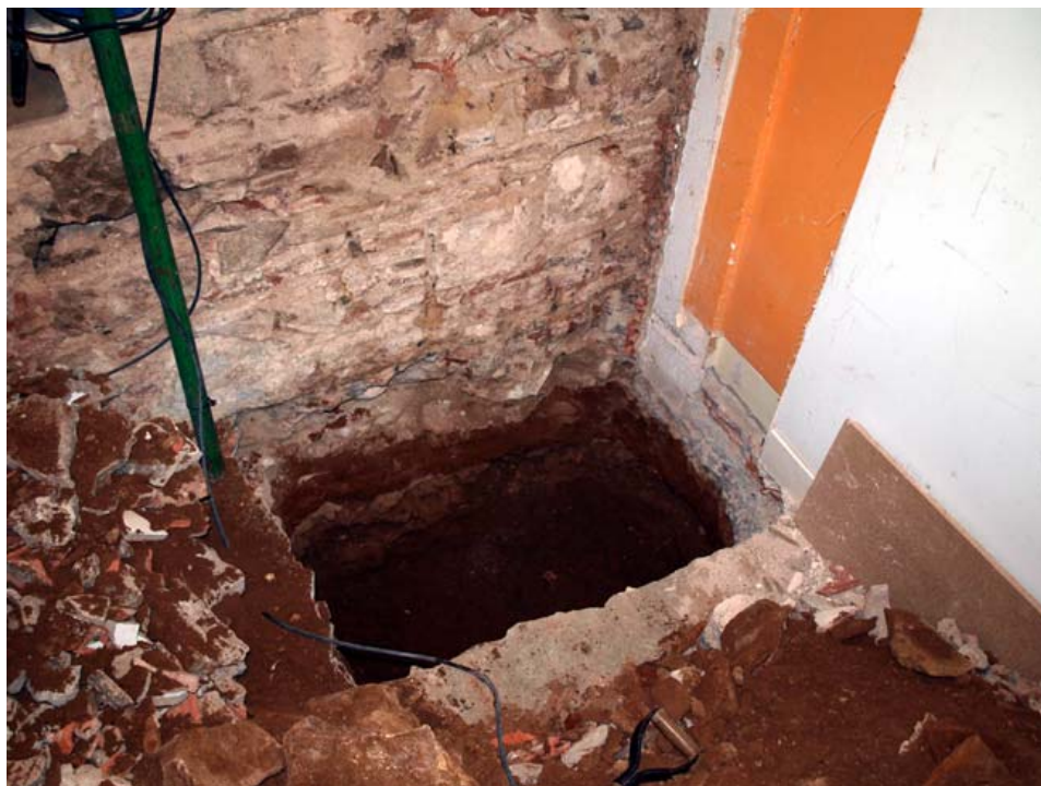
FOTO 3: Vista del parament de l'escala Ue 107.
